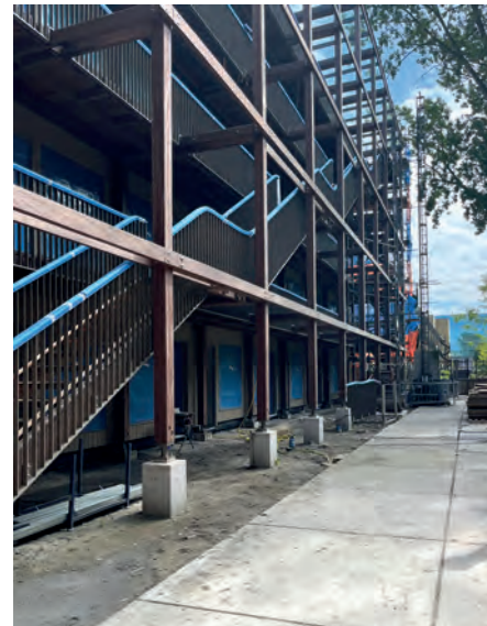
FOTO: HEREN 5 ARCHITECTEN
